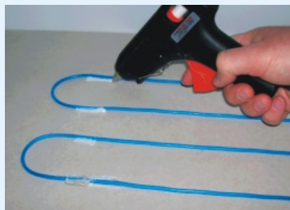
Jeden ze sposobów ułożenia przewodów grzejnych ELEKTRA DM
