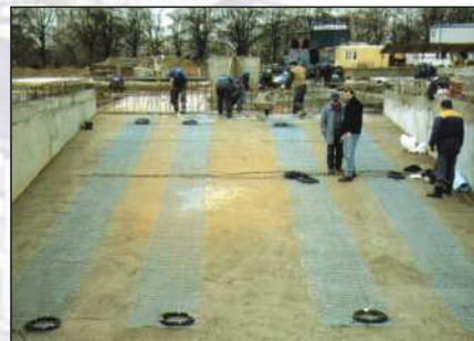
Ekipa instalacyjna ELEKTRY w Wiśniowym Business Parku.
