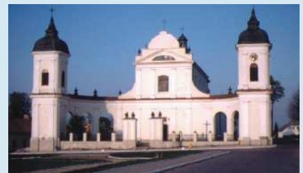
Kościół w Tykocinie - 400 m 2 powierzchni grzejnej.
