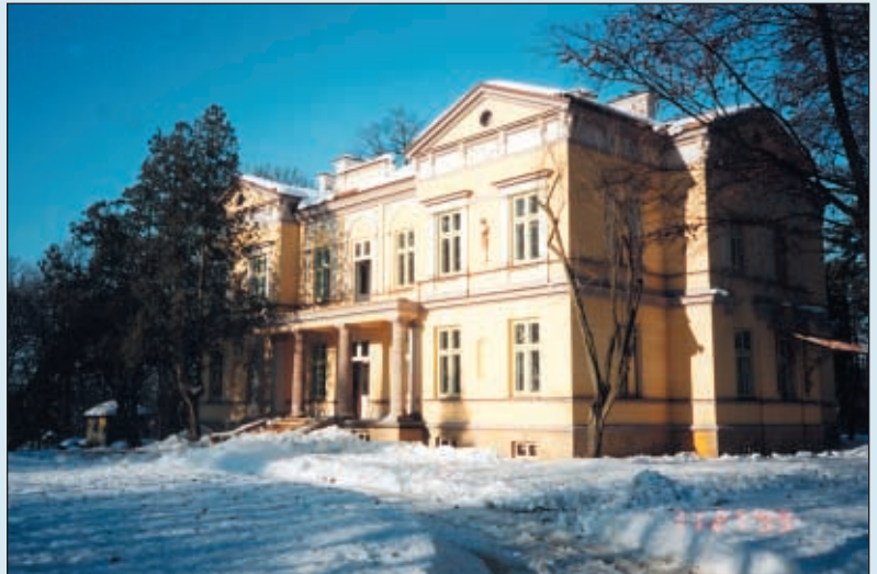
Zespół parkowo-pałacowy Jabłonna k/Lublina. Instalacja ochrony przeciwoblodzeniowej rynien i rur spustowych. Ogrzewanie podłogowe w łazienkach i holach.
