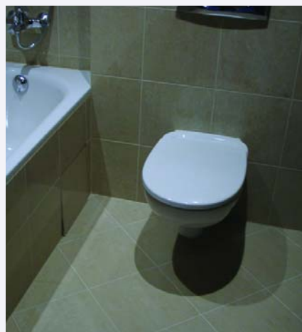
Jedna z łazienek, w której została zainstalowana mata grzejąca Elektra
