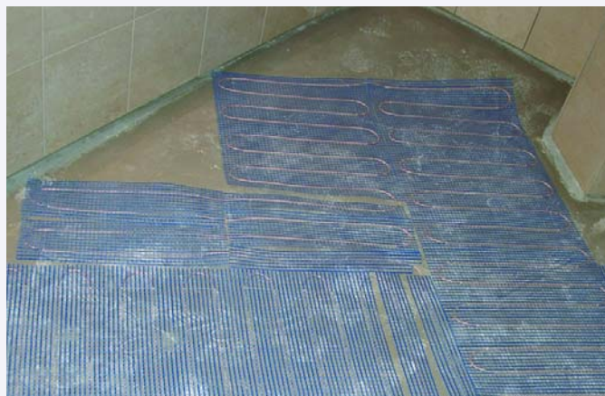
Sposób ułożenia mat grzejnych w jednej z hotelowych łazienek
